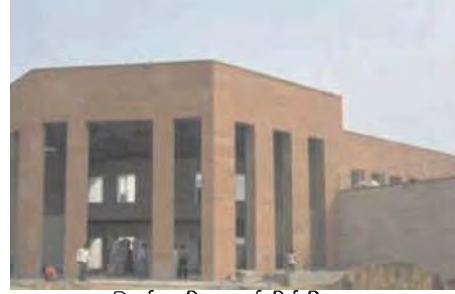
निर्माणाधीन आईसीईडी भवन
