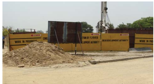
खेल गाँव के समीप फ्लाईओवर का निर्माण
